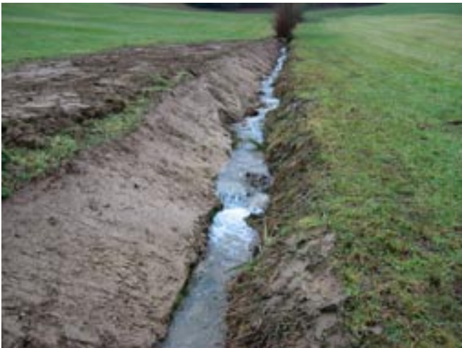
Der Bach nach der Wiederherstellung durch den Gewässerunterhalt des Kantons Aargau.
