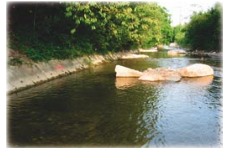
Nachher: Kolmatierung aufgelöst, Steine als Strömungslenker
